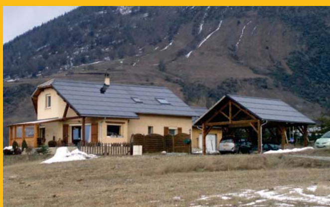
Intégration de modules photovoltaïques sur trois pans de toiture avec traitement soigné des pourtours de velux et cheminée grâce à des tuiles fictives.
