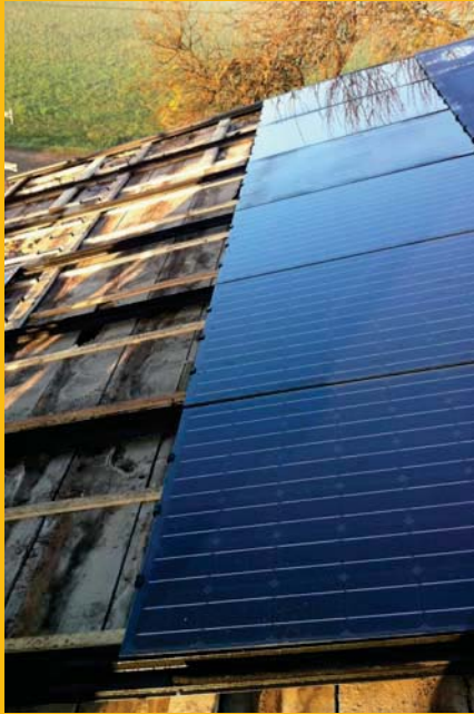
Le photovoltaïque au service de la rénovation des toitures
